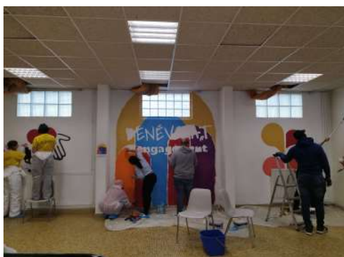
Chantier citoyen, samedi 26 avril 2025
